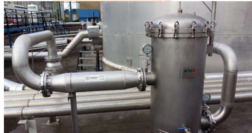
Instalación en Bilbao
